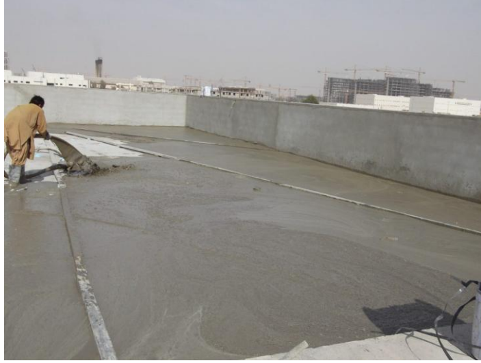
الشكل- ٣: سقف منفذ باستخدام الخرسانة الرغوية (٥)
