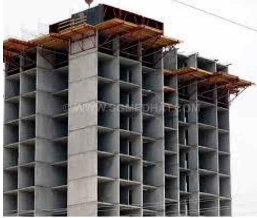
الشكل ٥:- بناء باستخدام الشدات النفقية (٩)
